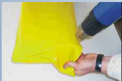
Zdj. 11a-d - Powlekanie łuku na krawędzi
