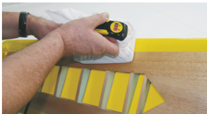
Abb. 10b Bebügelung fertig stellen
